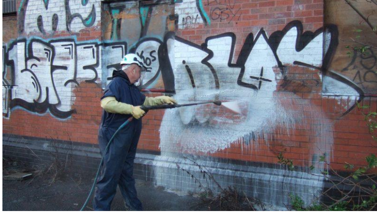
Şekil 7. Basınçlı Suyla Buff Uygulaması Yapan Bir İşçi
